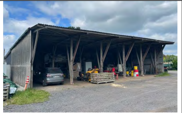
Bild 2: Ostseite der Unterstellhalle für Baufahrzeuge und Maschinen an der Nordheiderstraße.
