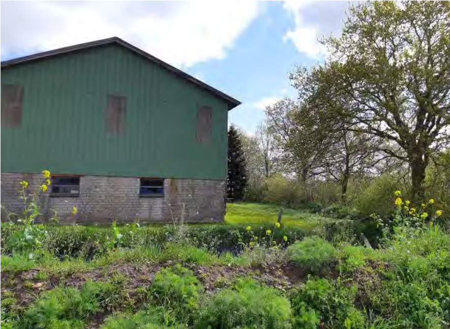
Abbildung 10: Bestandsgebäude im SO2
