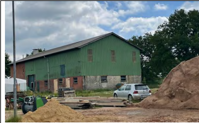
Bild 1: Ehemalige Bauernstelle mit Scheune und Wohntrakt des Eigentümers Herrn Thedens an der Nordheiderstraße (Blick aus Richtung NW).
