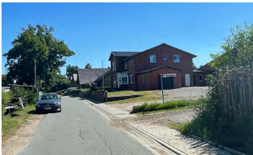
Abbildung 7: Bestandswohnnutzung an einer vermeintlichen Zuwegung zu dem möglichen Standort für die Ansiedlung des Lohnunternehmens der Fa. Thedens an der Dorfstraße ( Blick aus Nordwesten )
