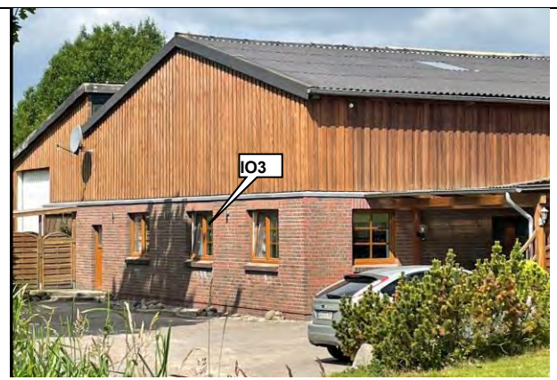
Bild 8: Immissionsort IO3 (Wohnnutzungen in der ausgebauten Scheune auf dem benachbarten Grundstück)
