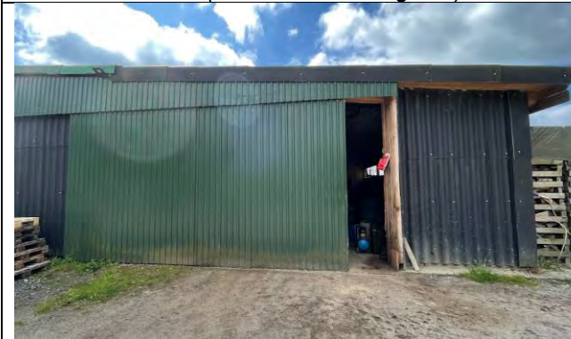
Bild 3: Nordseite der Unterstellhalle für Baufahrzeuge und Maschinen am Wennjenweg.
